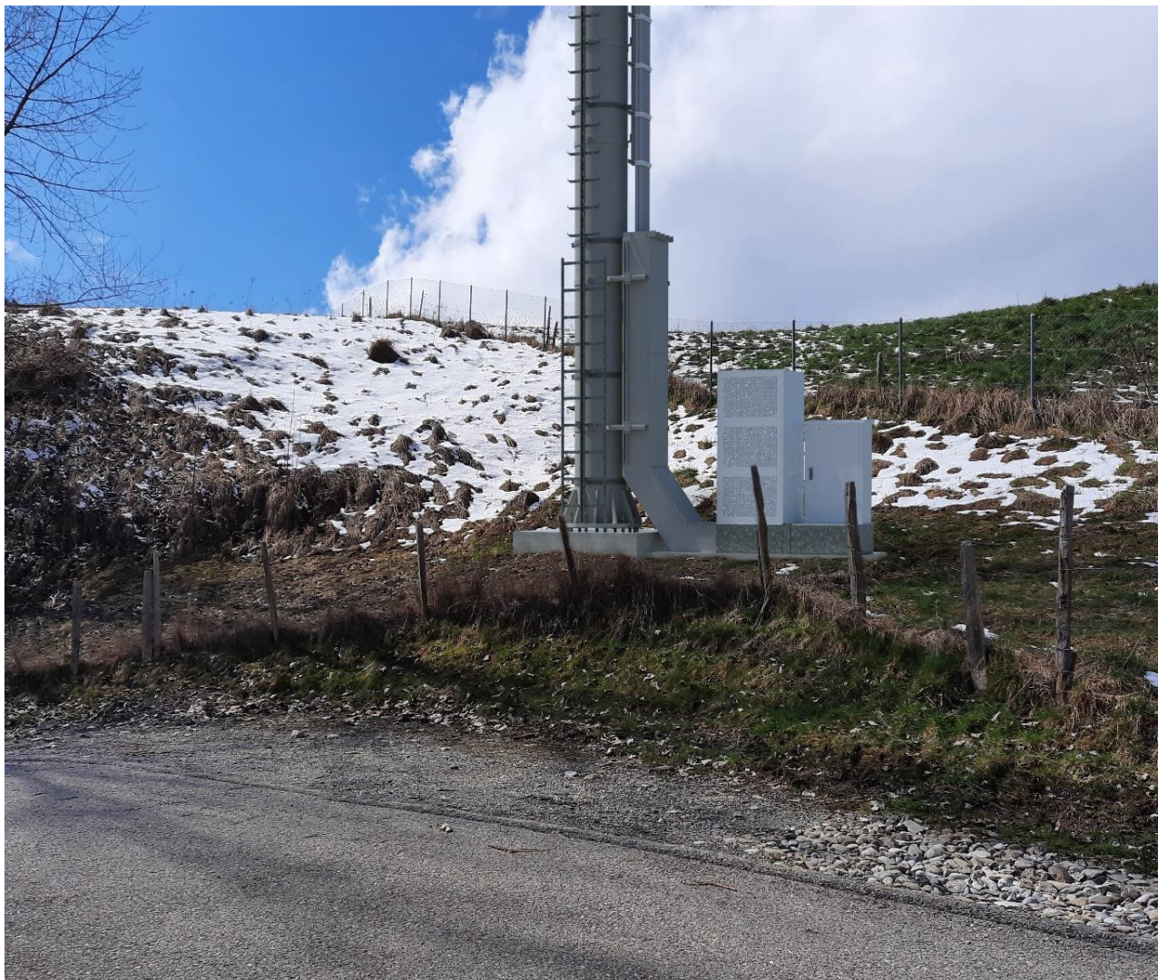
Pied du mât avec équipements techniques, emprise au sol \sim 3,7 \text{ m}^2
