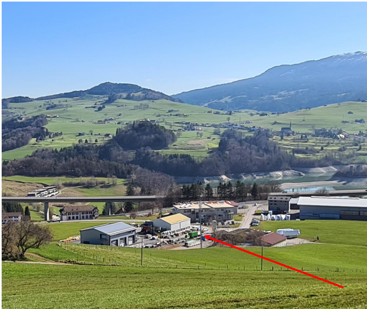
Vue Ouest : Mât hauteur 30 m
